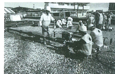
仮設給水栓設置(宇管工青年部)
