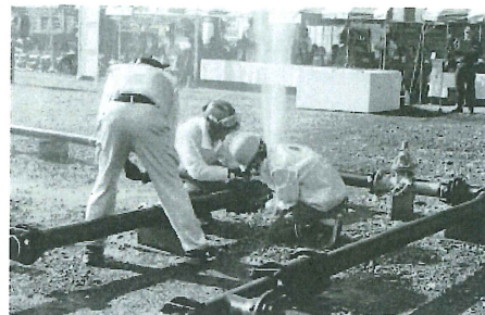
配水管漏水修理(宇管工青年部)
