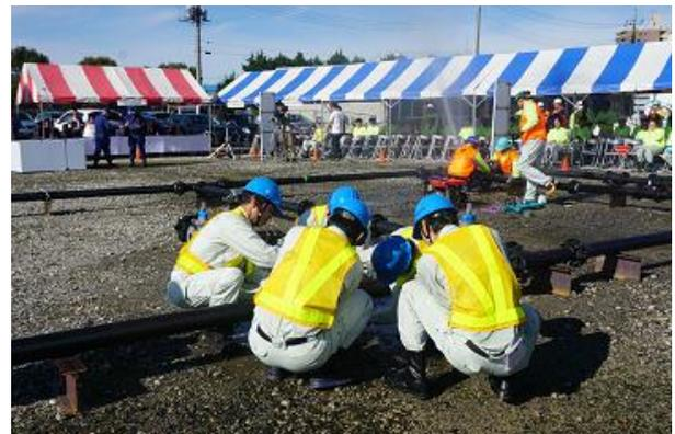
配水管漏水修理(大田原管工事工業協同組合)
