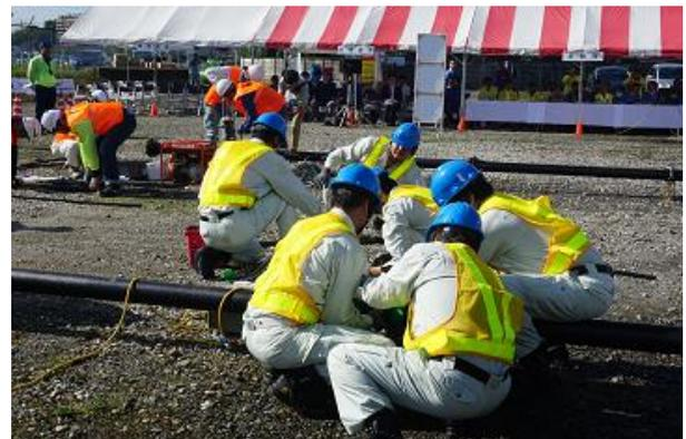
仮設給水栓設置(大田原管工事工業協同組合)
