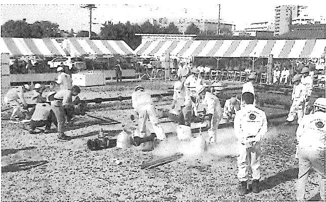
中村委員長の号令による参集訓練(上)と応急復旧訓練(下)
