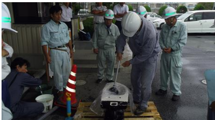
実技「蛇口や便器の水漏れ修理等」(横島講師)
