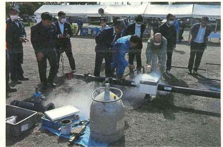
液体窒素を使用した凍結工法
