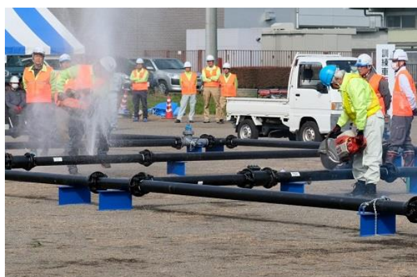
配水管に切れ目を入れる訓練参加者
