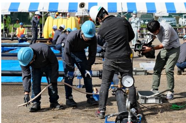
仮設給水栓設置（県立産業技術専門校①）
