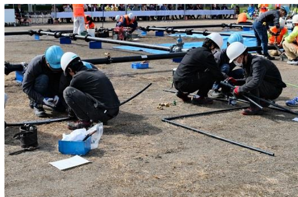
仮設給水栓設置（県立産業技術専門校②）
