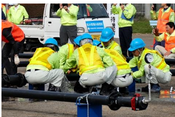
配水管漏水修理（大田原管工事工業協同組合）
