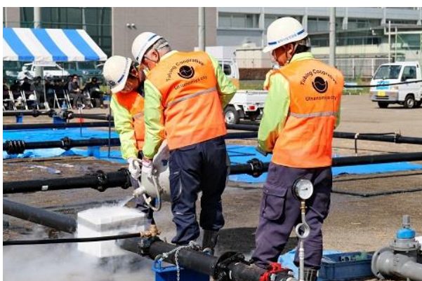
凍結工法訓練（㈲今川住宅設備）
