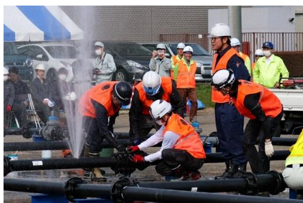
配水管漏水修理（足利市上下水道設備事業協同組合）
