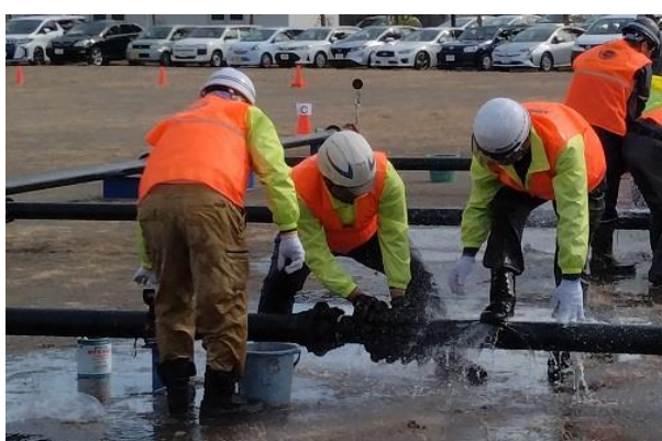
配水管漏水修理（青年部①）
