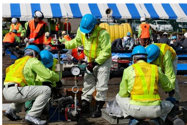
仮設給水栓設置（大田原管工事工業協同組合）
