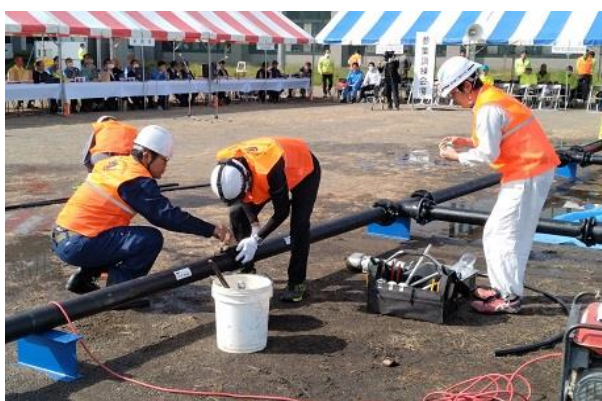
仮設給水栓設置（足利市上下水道設備事業協同組合）
