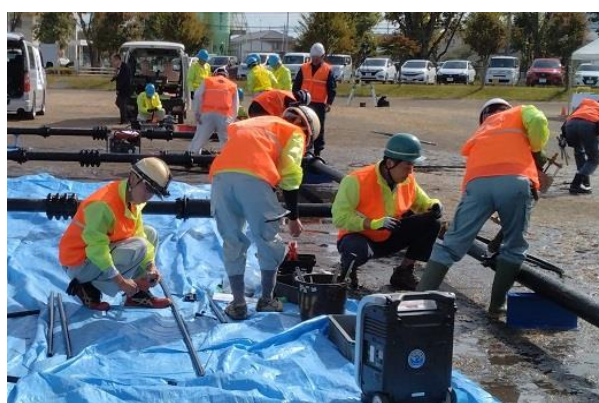
仮設給水栓設置（青年部②）
