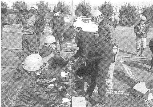
青年部から手ほどきを受ける建築設備科の訓練生
