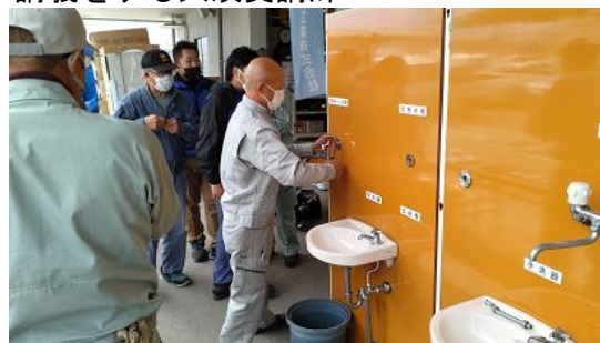
水漏れ補修を体験する参加者
