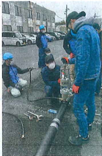
分水作業の実技指導を受ける訓練生たち＝8日午前、宇都宮市
